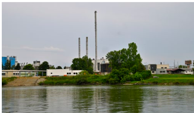
Slika 1: Zunanji pogled na novo postrojenje za pripravo pitne vode
