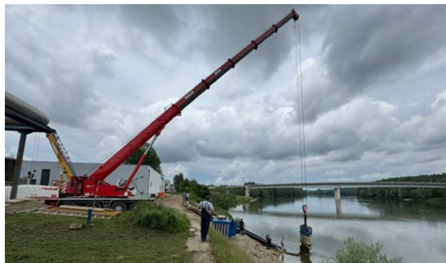
Slika 9: Faza gradnje (odstranjevanje zagatnic)
