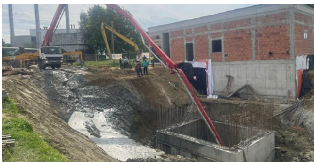
Slike 3-5: Faza gradnje (vstopni jašek - foto zgoraj, in črpališče - foto spodaj)
